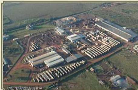
Centro Industrial Virasoro, provincia de Corrientes.
